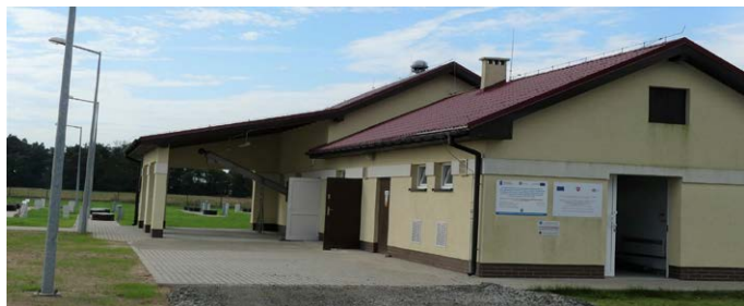
Ryc. 5. Gminna oczyszczalnia ścieków w Godzieszach Małych
