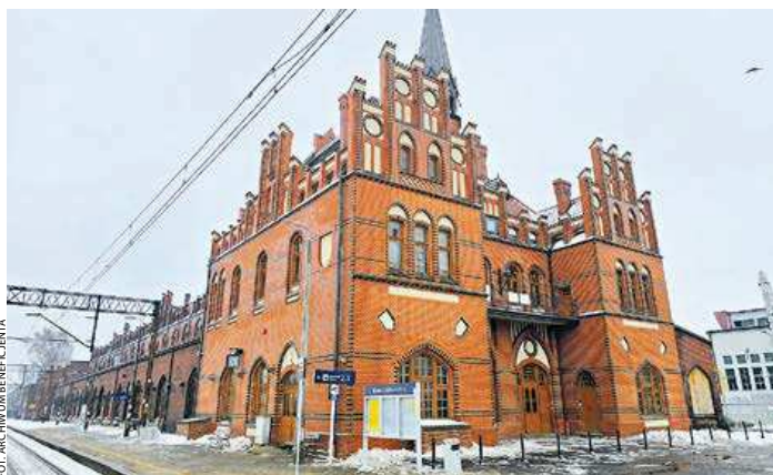
Rewitalizacje dotyczą reprezentacyjnych budynków, jak dworzec w Nowych Skalmierzycach.
