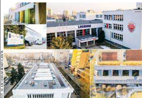
Tak wyglądają budynki po modernizacji.
