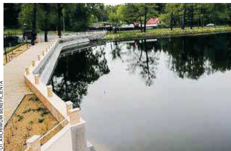
Modernizacja zbiornika „Szperek” w Antoninie.
