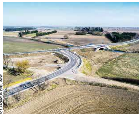
Przebudowano skrzyżowanie i most na DW 197.
