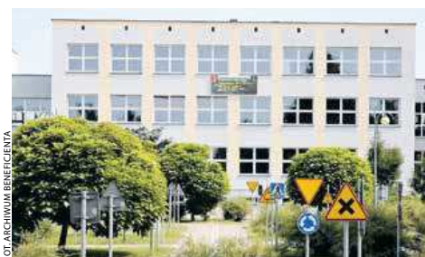
Szkoła w Rychwale po termomodernizacji.
