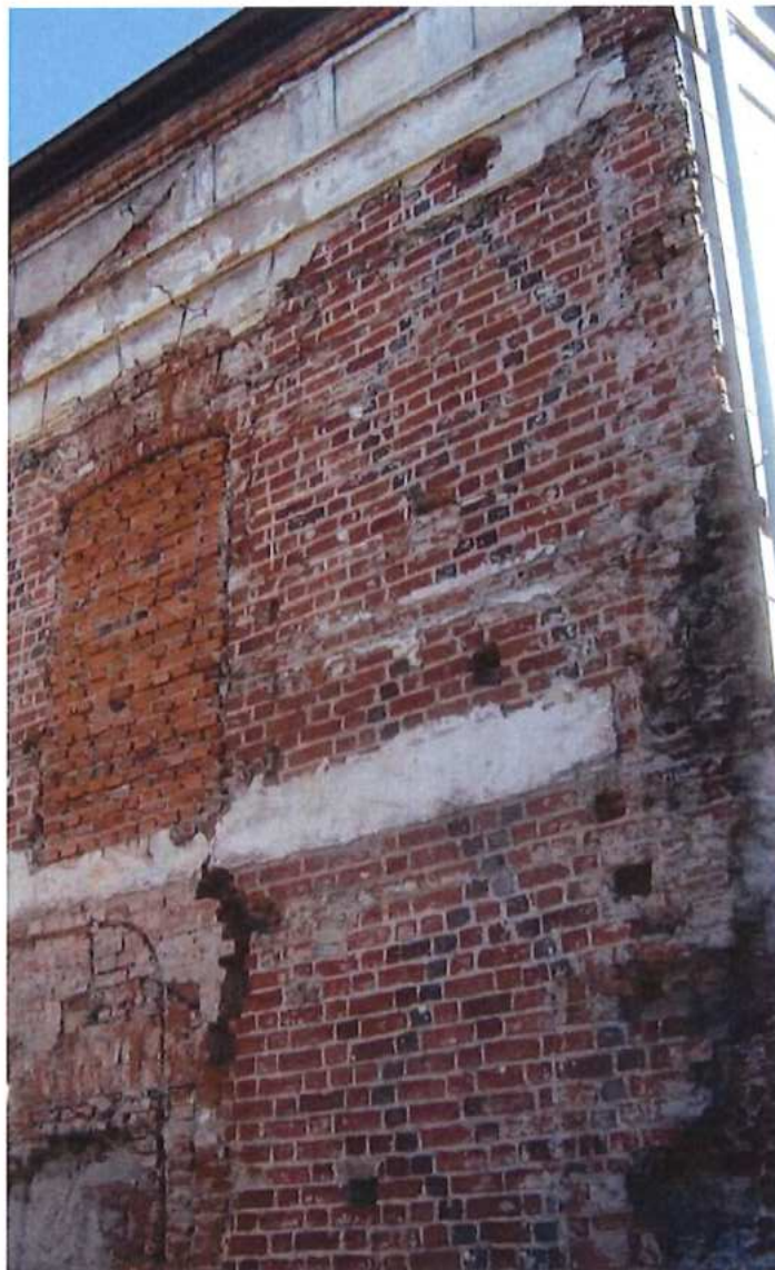
Odsłonięta podczas remontu ściana ratusza z widocznym ornamentem.
